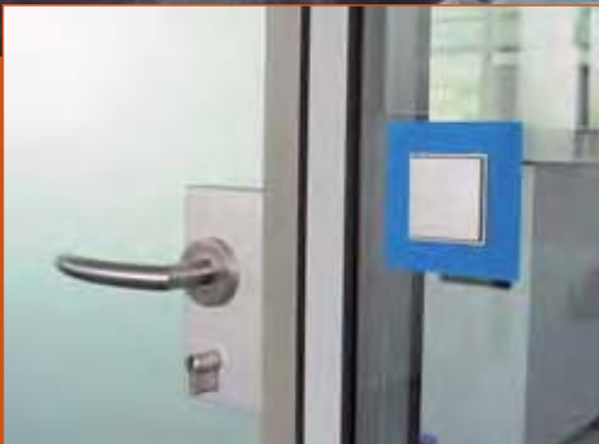
EnOcean easyfit-Universal-Schaltereinsatz für 55 mm x 55 mm Rahmensysteme mit energieautarkem Funk-Sendemodul PTM 200.
